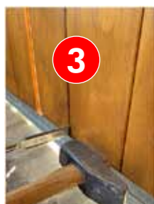
Répartir les frises l'une après l'autre à espace égal en commençant par la plus proche de l'ajourage.
